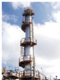
Figura 1.59 En la torre de destilación se separan por diferencia de temperaturas muchos de los componentes del petróleo.
