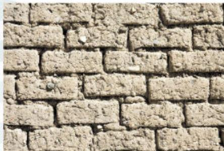
Figura 5.18 Pared construida con bloques de adobe
